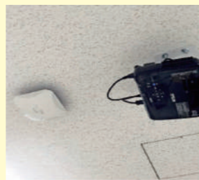
校内に張り巡らされた無線LANネットワーク
